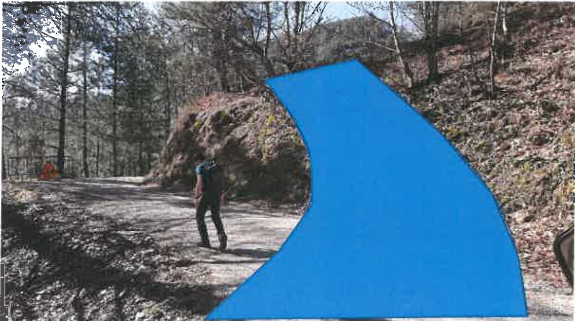
Figure 11 : Création d'une rampe en remblais pour accès à la partie haute du chemin de Perry
