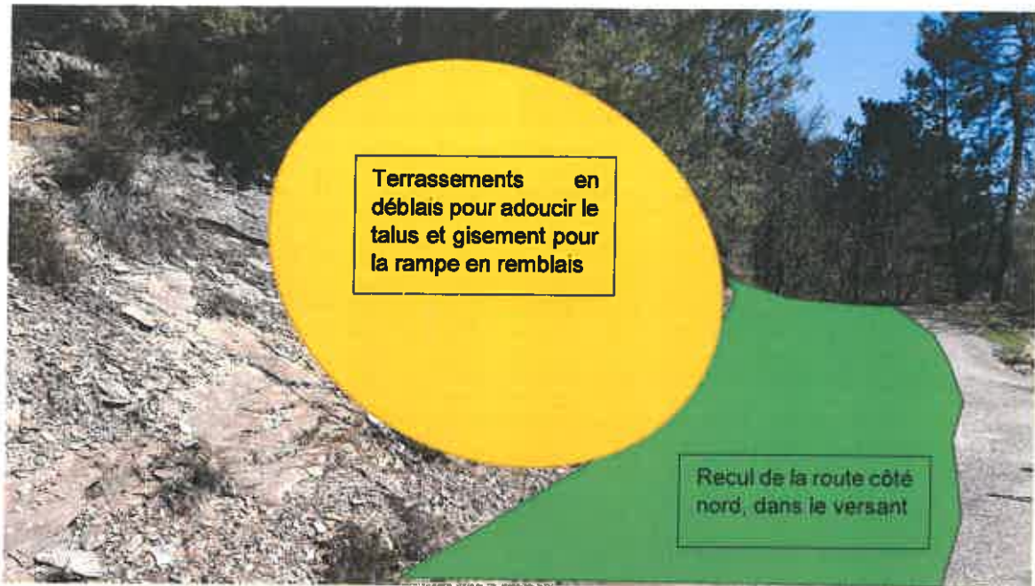
Figure 12 : Recul de la route dans le versant et terrassements en déblais
